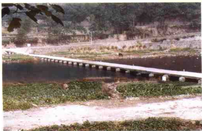
鸡冠山漫水路面
