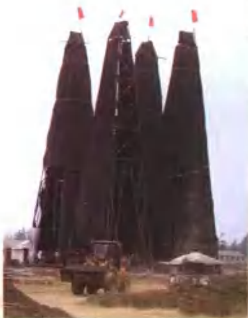
▲ 杨柳煤矿副井注浆施工
