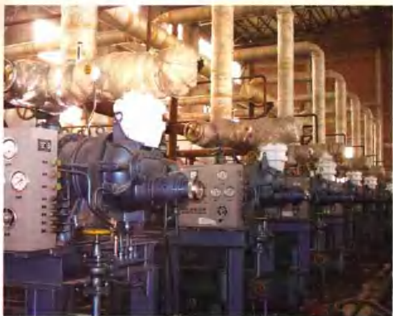
▲ 顾桥煤矿副井冻结施工
