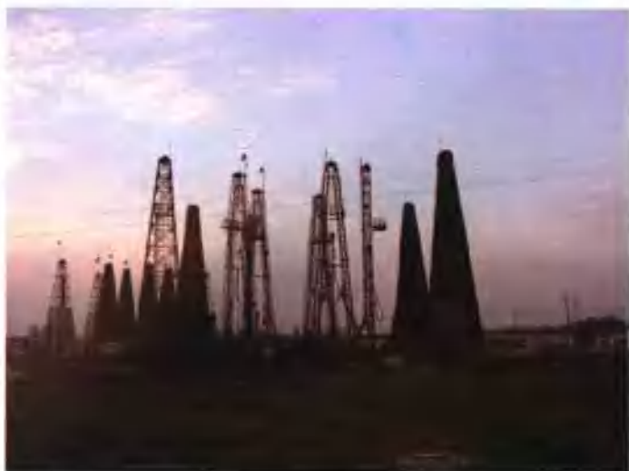
▲ 刘庄煤矿西区进风井注浆施工
