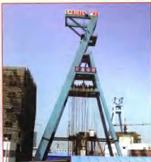
▲ 建设中的顾北煤矿
