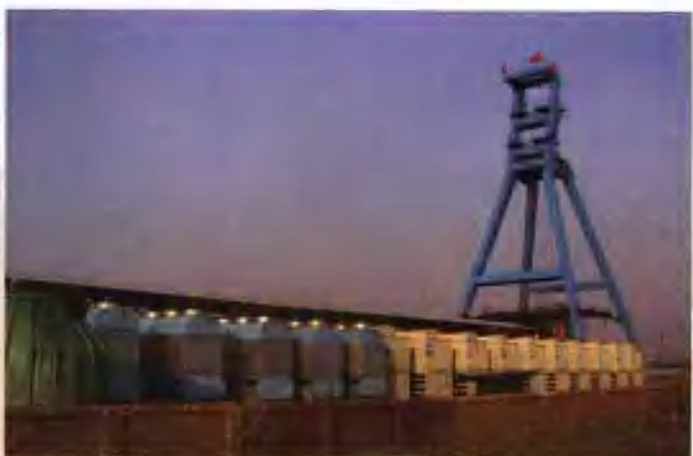
▲ 赵官煤矿主、副井冻结施工
