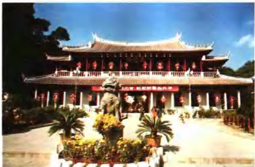
歇山顶（威远楼）
