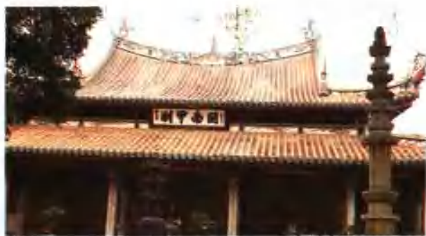
重檐歇山顶（承天 寺大雄宝殿）
