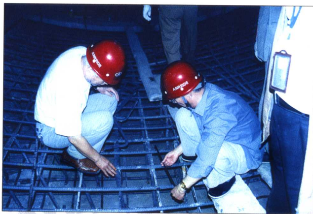
水利部质量监督站和业主在检查钢筋绑扎质量
