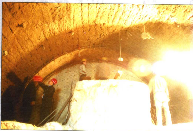
顶山隧洞实行分部开挖，上导洞开挖后立即进行一次支护。照片为上导洞开挖与一次支护后的情况，喷射混凝土壁面平整，格栅拱架安装质量优良
