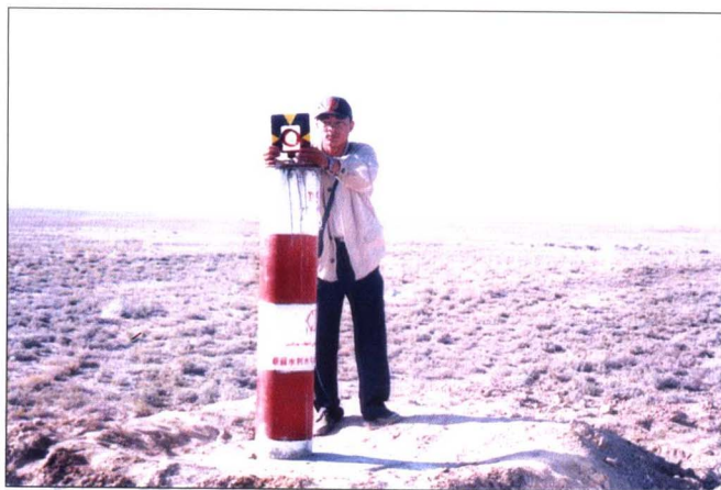
在渺无人烟的戈壁滩中，测量人员进行放线，开始顶山隧洞的建设
