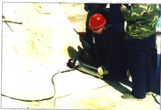
顶山隧洞出口进行自进式锚杆拉拔试验
