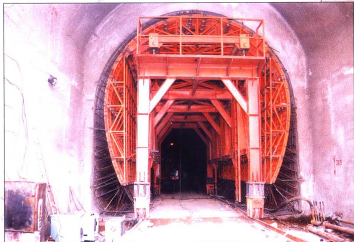
顶山隧洞已经组装调试完好的钢模台车， 准备第一仓混凝土浇筑
