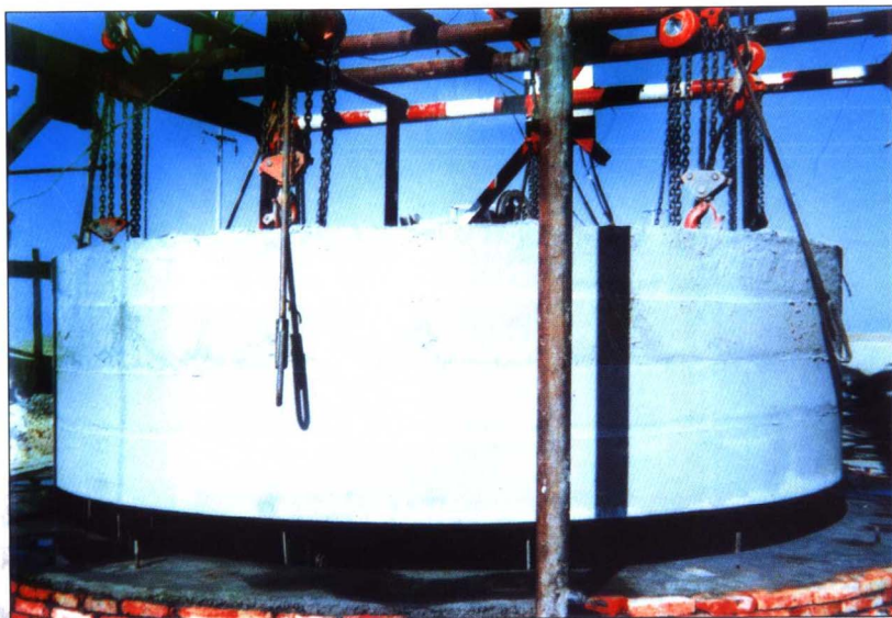
顶山隧洞竖井加固所使用的滑模系统
