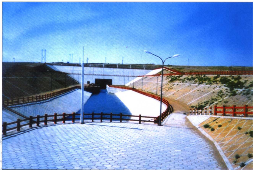
顶山隧洞进口全貌
