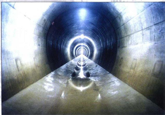
混凝土衬砌完成后，顶山隧洞全貌
