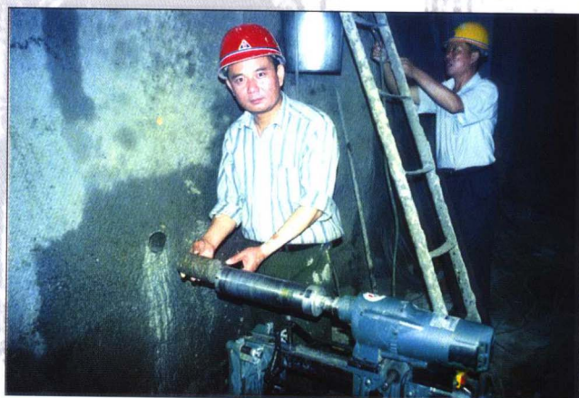
顶山隧洞 II 标段试验站人员和驻竖井技术人员在 7 号竖井上游段对一次支护喷射混凝土钻芯取样进行质量检查
