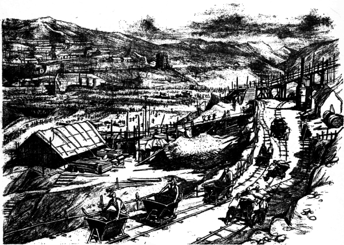
12. 水庫工地 1953 年作
