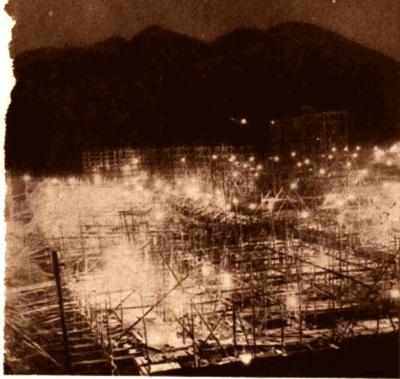
攔河閘工地之夜。
