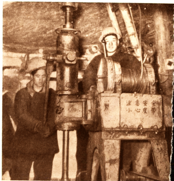
为了给设计提供精确的资料，鑽工們正在鑽岩心。
