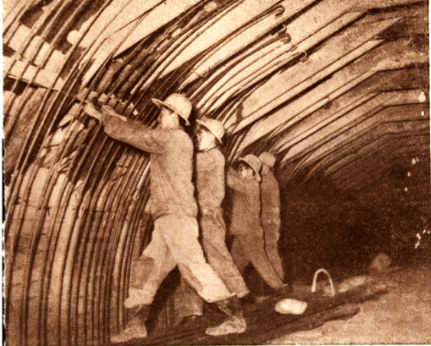
鋼筋工正在緊張地扎綁隧洞鋼筋。
