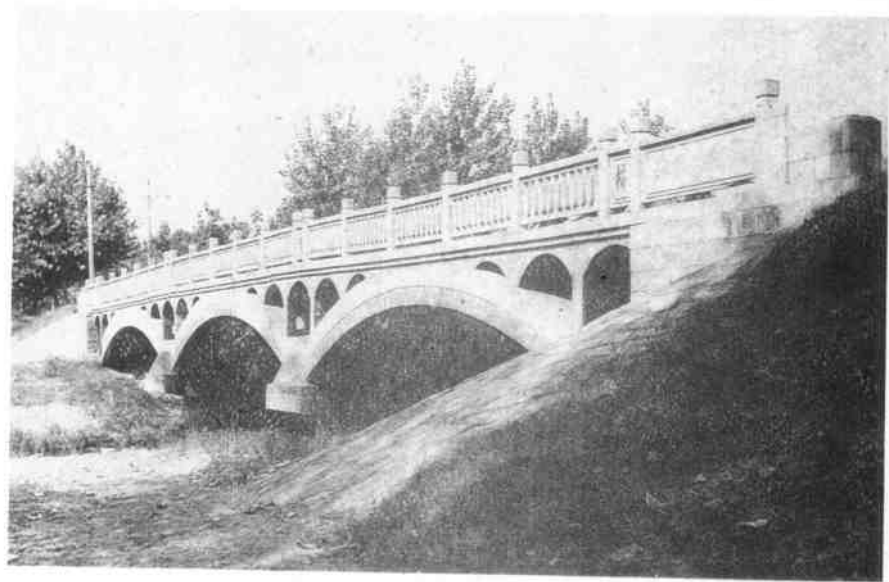
商丘包河双曲拱公路桥
