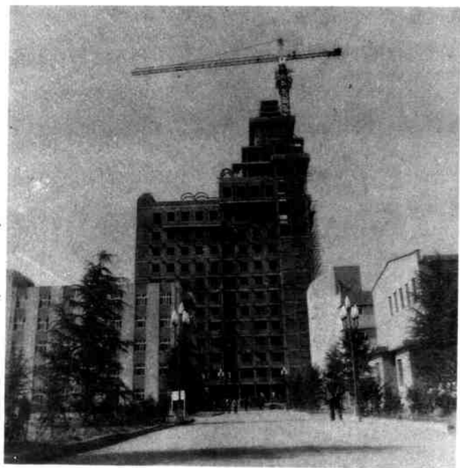
商丘供电局 调度楼
