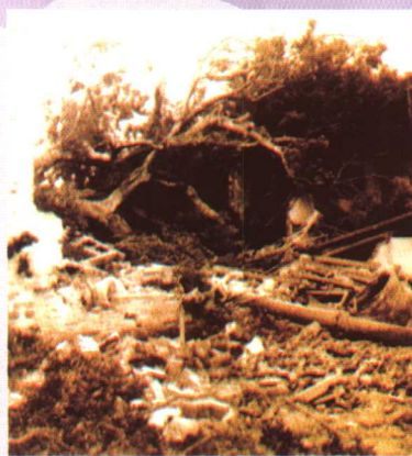
1979年4月19日，被龙卷风吹翻的大榕树压塌厚街白蚝大队部及幼儿园的房屋。
