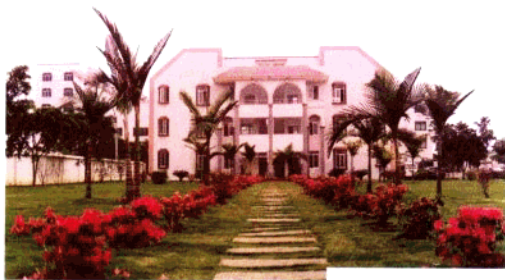
◀ 高新区浦发汽车空调有限公司设计办公大楼。
