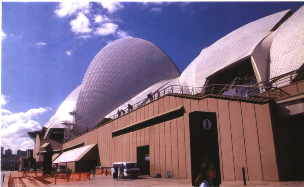
随后几年中，工程遇到了一系列的问题，尤其是最关键的歌剧院壳形屋顶的建造，大大超越了当时的工程技术水平。1962年1月，乌重通过采用基于几何球体的拱形混凝土肋骨方案，圆满解决了屋顶建筑的难题；3月，球形解决方案获得批准。此后，工程遇到一系列困难，经费严重短缺，大大超出预算，引发争议，并成为当时政治争论的焦点之一。
