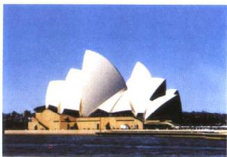
歌剧院最引人注目的壳形屋顶由2,194块预制水泥板组成，每块重约15.5吨，屋顶总重量27,230吨。整个建筑由580根钻入水下25米的水泥柱支撑，顶部则由32个面积为2.5平方米的水泥柱支撑。整个建筑共用水泥12.5万吨，剧院总重量为16.1万吨。
