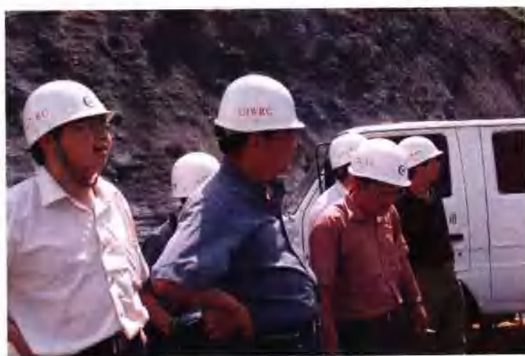
长江勘测规划设计研究院副总 工程师黄纪辛(左三)与地质公 司总工程师冯明权(左一)在 乌江彭水水电站施工现场检查 工作
