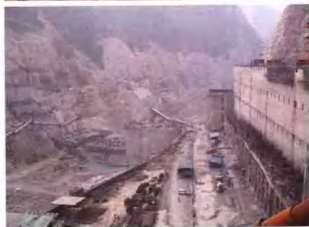
在建的乌江彭水水电站
