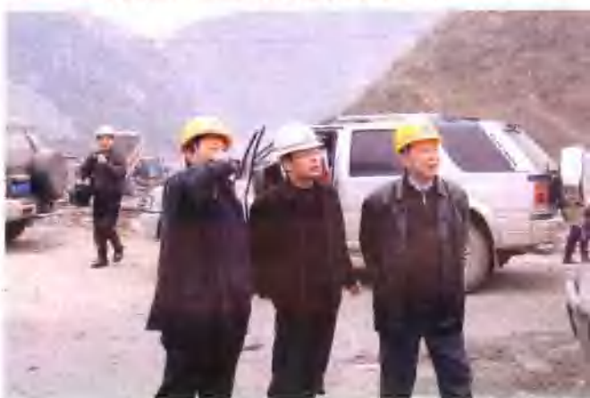
长江岩土工程总公司副总工程师陈文理(中)在乌江构皮滩水电站施工现场向专家介绍情况
