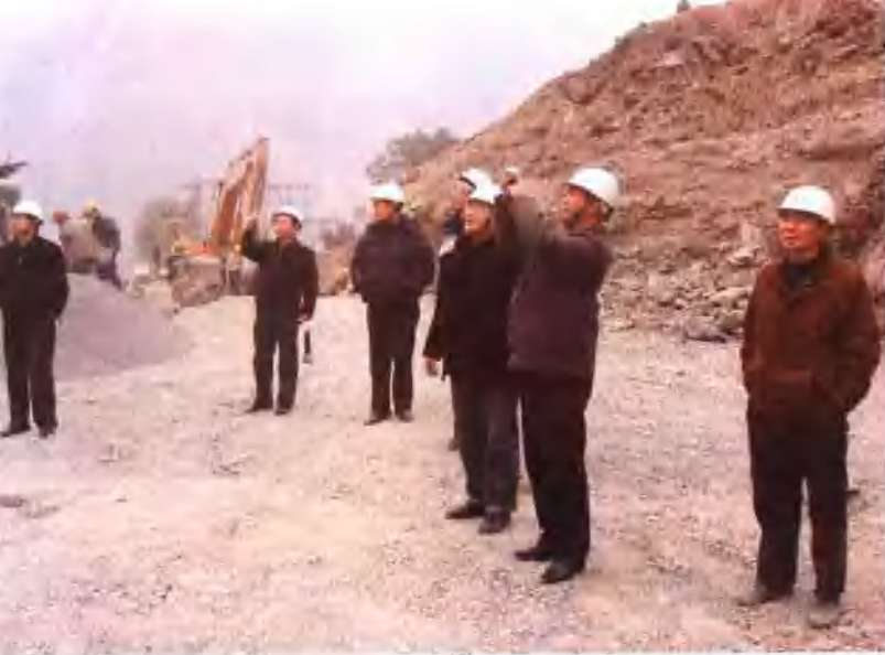
地质公司领导马贵生(右二)、易名龙(左一)在乌江银盘水电站施工现场检查工作
