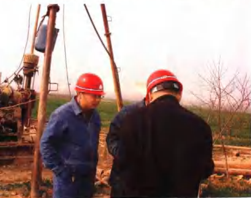
地质公司副经理赵旻(左)在南水北调中线勘测现场检查工作
