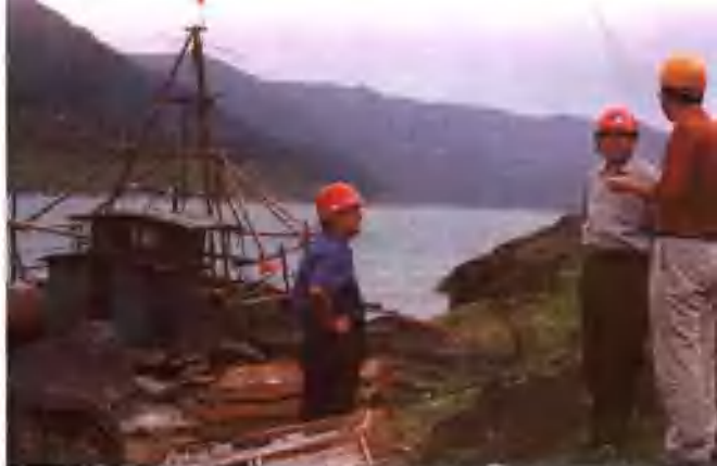
长江岩土工程总公司副总经理范子福(中)在嘉陵江亭子口水利枢纽勘测现场检查工作
