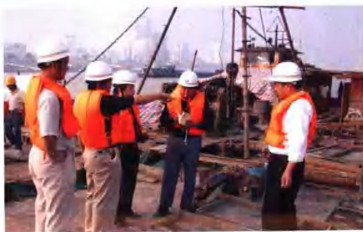
长江勘测规划设计研究院副总 工程师吴永峰(左二)与地质公 公司领导马贵生(左一)、罗小杰 (右一)等在武汉地铁工程勘察 现场检查工作
