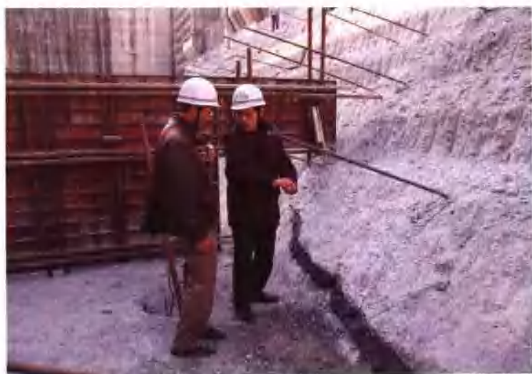
长江勘测规划设计研究院副总 工程师蔡耀军(右)在南水北调 中线水源工程现场指导工作
