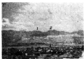
照3. 山宝鶴遙望秦嶺，羣峯峙立，1、2之間為綫路穿过的隧口。
