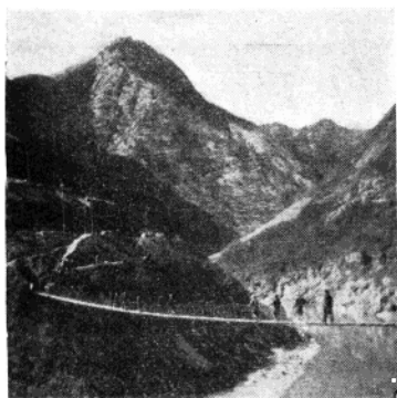
照11. 冥官峡是鳳州黃沙河段內的艱險峽谷區，嘉陵江到此僅寬三、四十公尺，工程艰巨。图中为施工时架設在嘉陵江上的鋼絲索桥。
