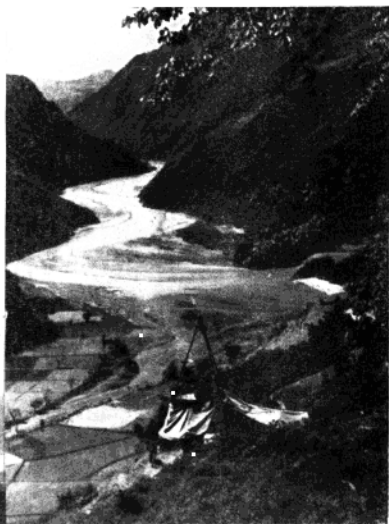
照 14. 人力鑽機進行鑽探→
