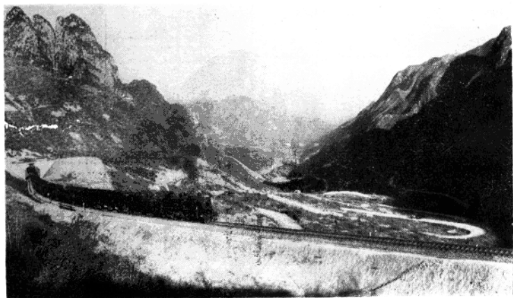
照10. 由秦嶺北望清姜河谷。這列客車從寶鵝出發穿 過 47 噸隧道，即將進入 2,364 公尺長的秦嶺大隧道。
