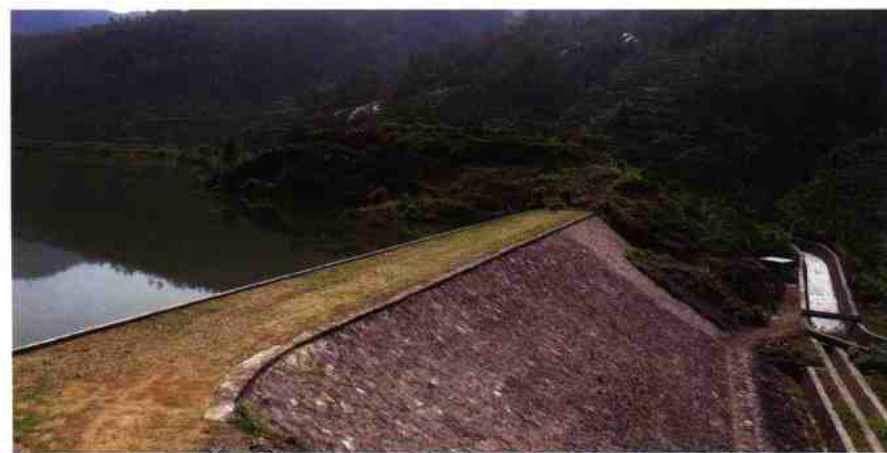
除险加固后的东坑弄水库
