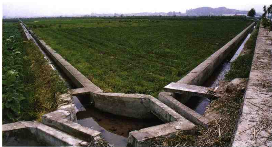
田间渠系配套工程
