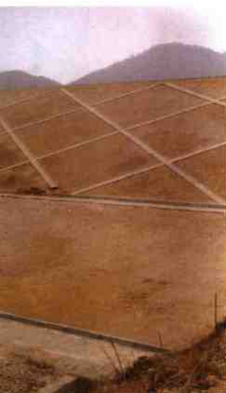
除险加固后的泉坑亭水库大坝
