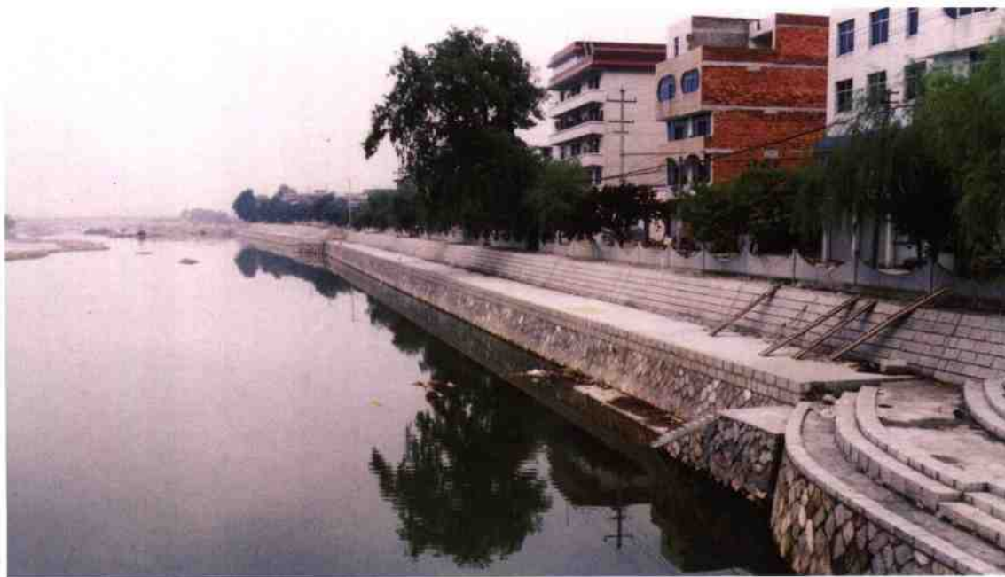
省防洪试点镇——古市镇一期防洪工程
