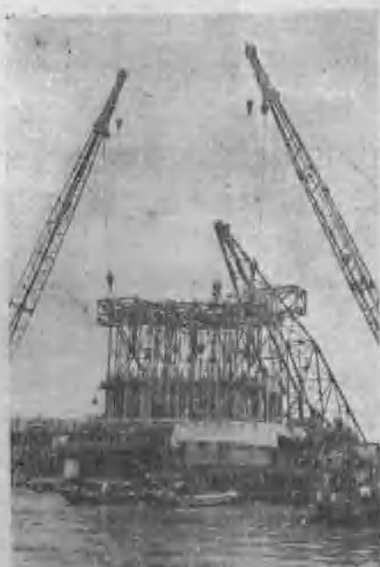
二号桥墩的围囿下沉时的情景 (新华社稿)
