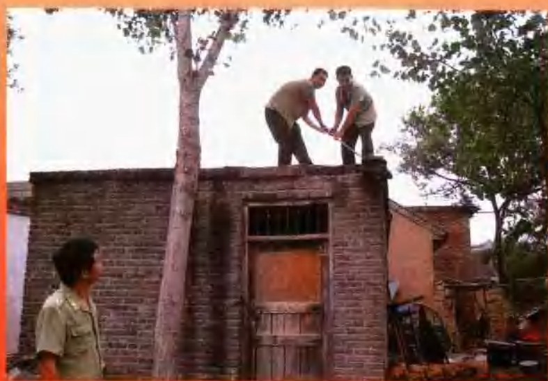
土地监察队依法拆除违法占地建筑
