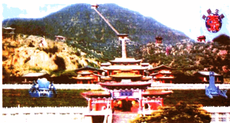
建设中的青阳园
