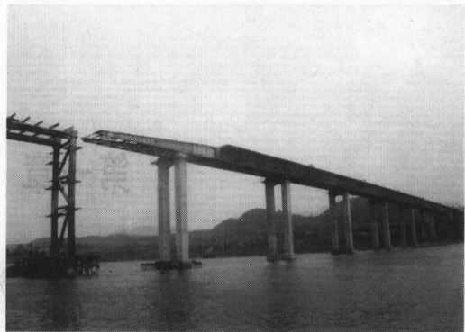
图 1-4 预应力混凝土连续梁桥顶推法施工
