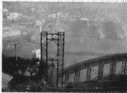
图 1-6 转体施工法
