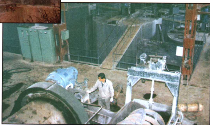
李坝金矿选矿车间
