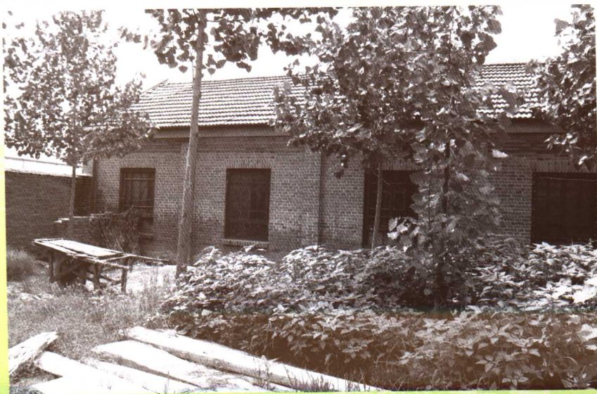
◀ 第三修防处驻 鄆城大渚潭旧址
