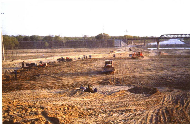
▶ 1987年9月，梁山国那里京杭运河顺黄船闸开始围堵
