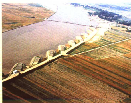
▲ 郓城黄河杨集险工上延工程
