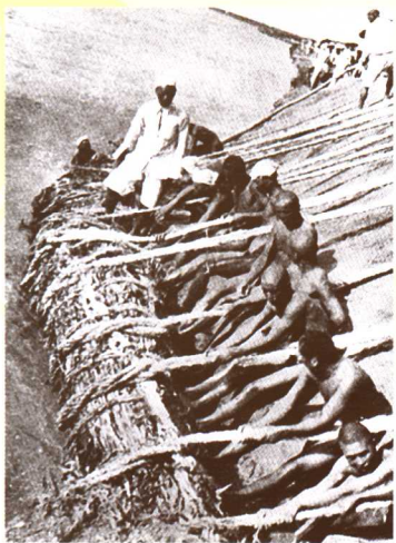
▲ 1948年，用柳石枕抢护高村险工坝岸
