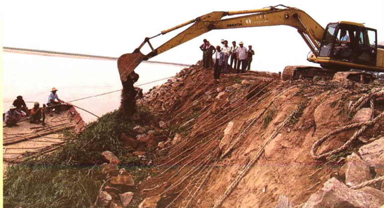
► 用船、挖掘机结合人力抢护黄河险工坝岸（摄于2004年）
