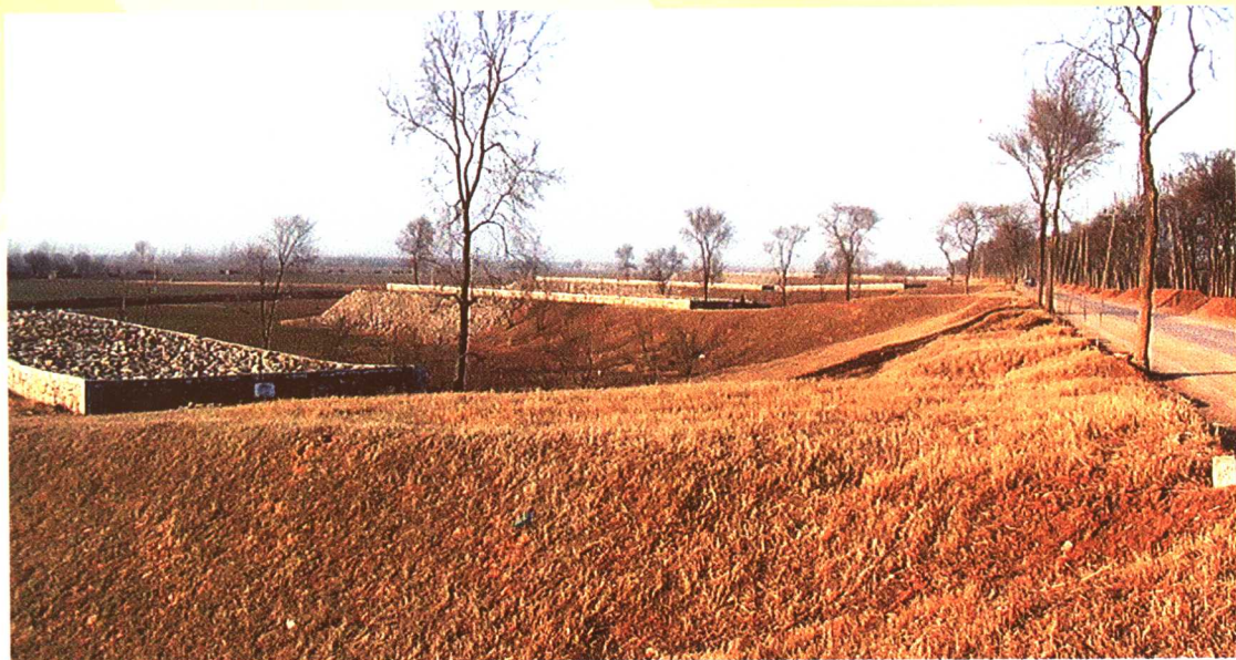
▲ 东明黄河滚河防护工程
