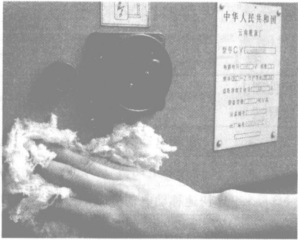
图 1—10 检查配电箱内
