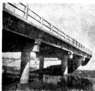
图 緒-2 双柱汽-10公路桥
