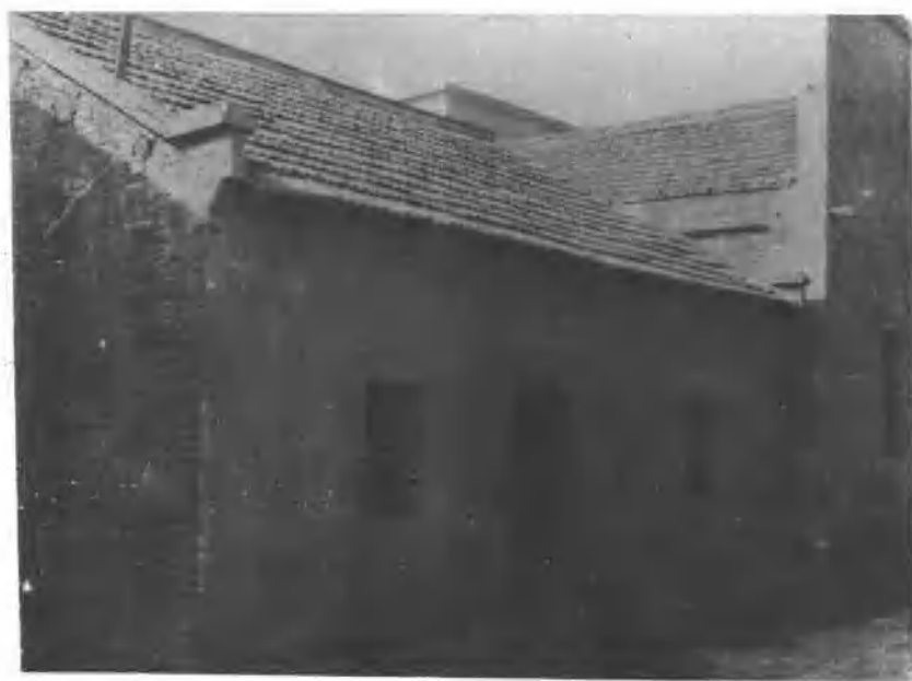
民国时期松滋县卫生院旧址（1945——1949）
