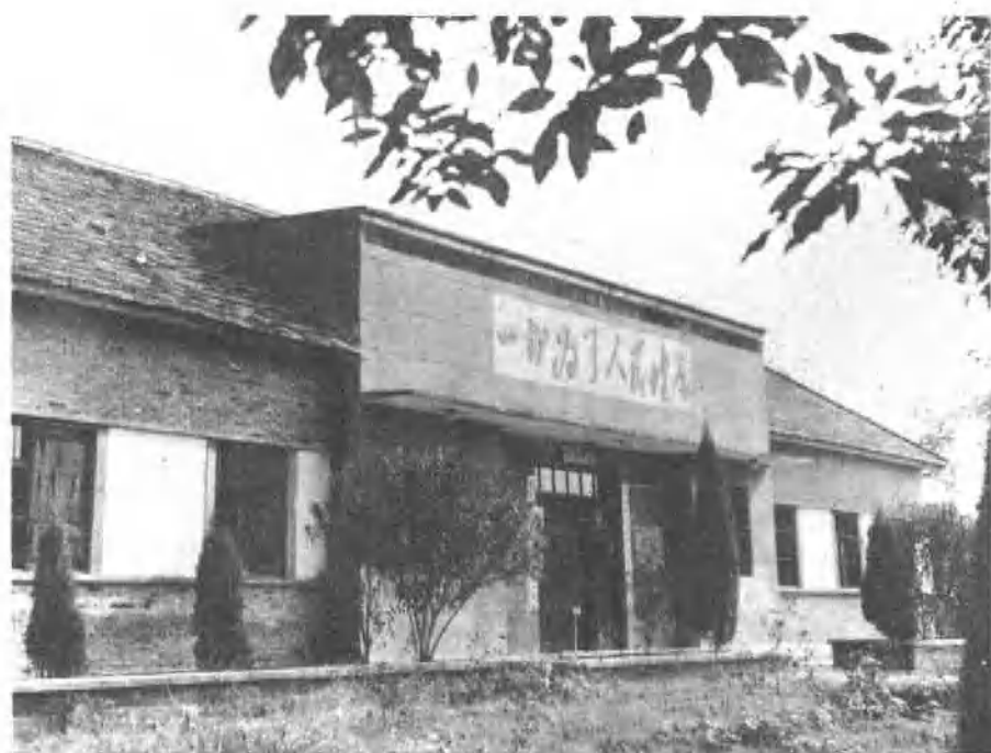
大岩咀区卫生院门诊部
