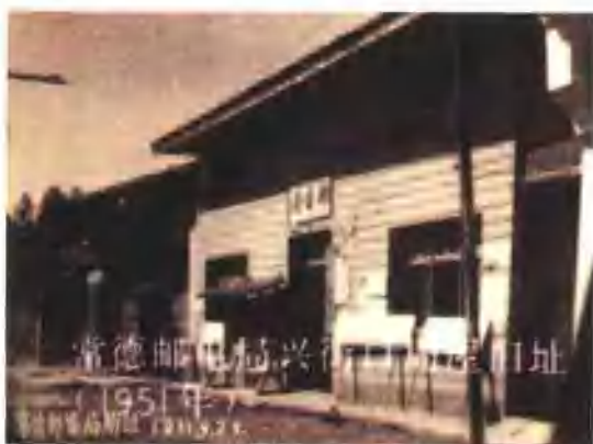
常德邮电局旧址(1951年)
