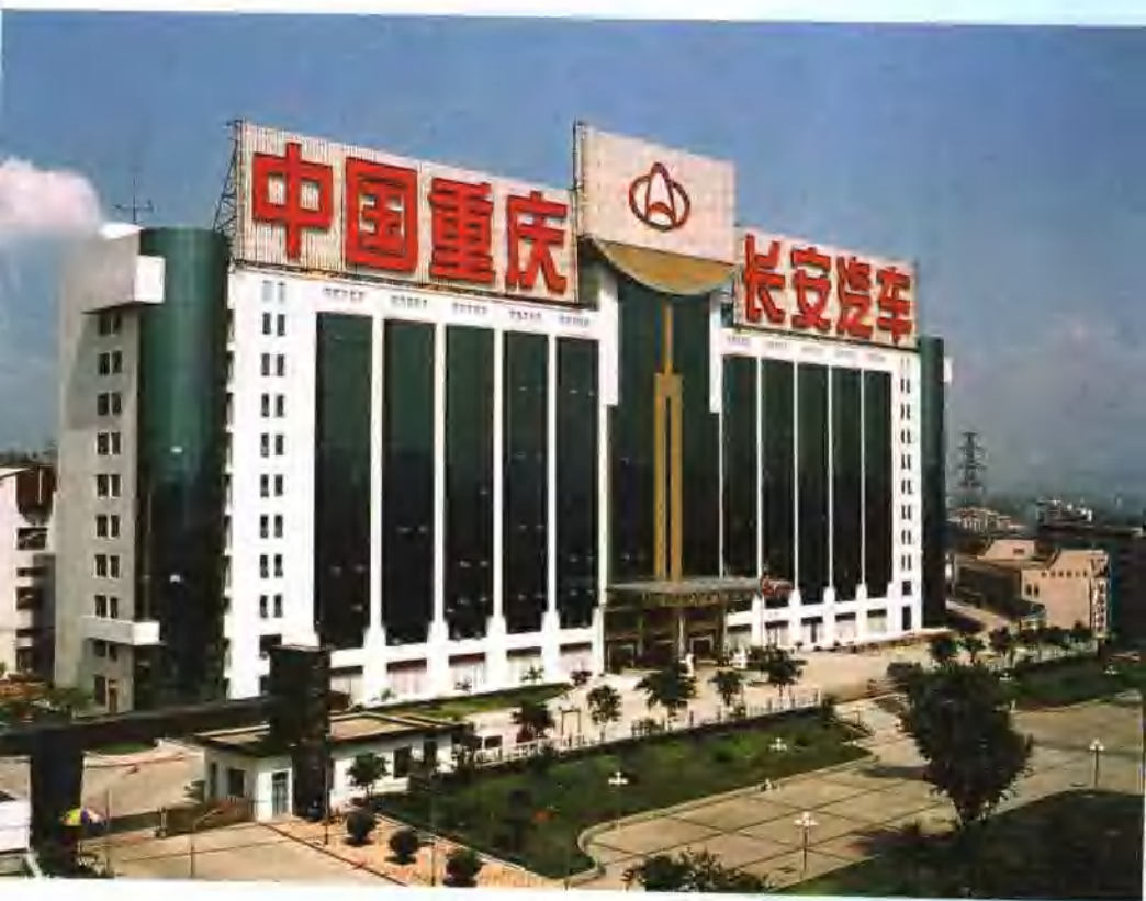
长安汽车集团总部大楼
