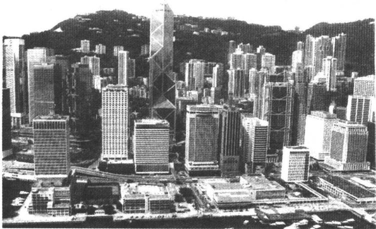
40 年之后,同样的地点,上一张照片中只有一幢建筑还依稀可辨。高耸的中国银行大厦位于图片的中央,其高度远远超过了右侧的汇丰银行新大楼。
