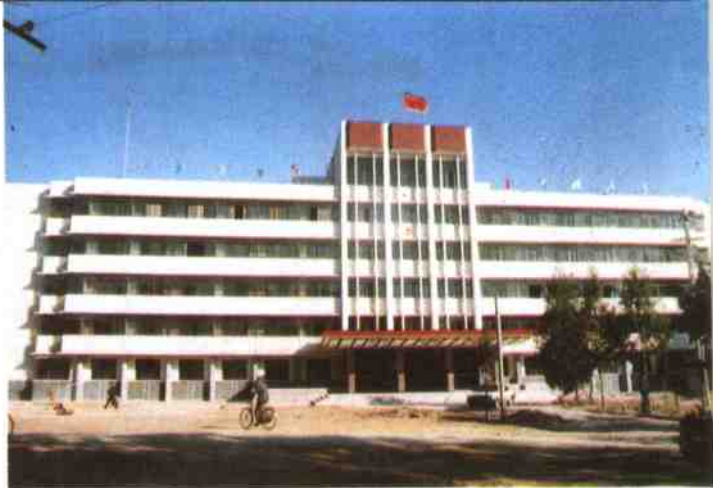
县政府办公大楼
