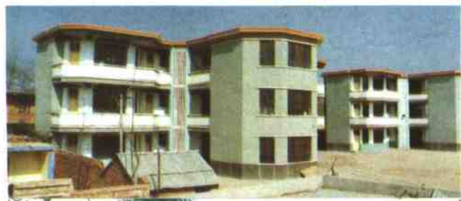
县直中学八角教学楼
