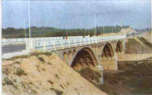
黄水河人民路大桥
