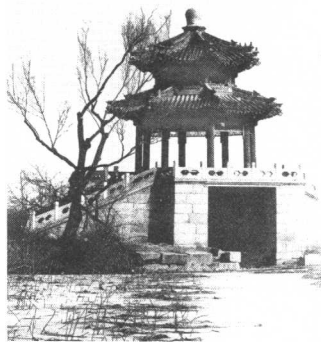
图18 颐和园西堤桥(《中国古建筑大系》)
