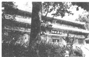
图22 潭柘寺大雄宝殿(《中国古建筑大系》)
