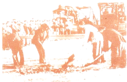
▲哈尔滨钢铁厂破土动工，职工们挖下第一锹土
