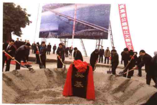
12月28日,乐(山)宜(宾)高速公路五通桥岷江大桥开工
