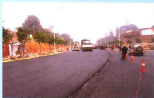
青果山道路施工现场
