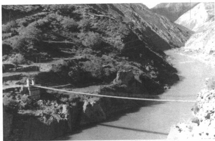
图二 纳西族商人赖耀彩等捐资修建的澜沧江上第一座近代化铁缆桥——溜同江普渡桥
