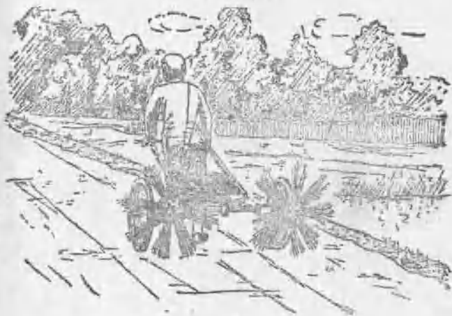
图6 使用扫砂車扫砂情况
