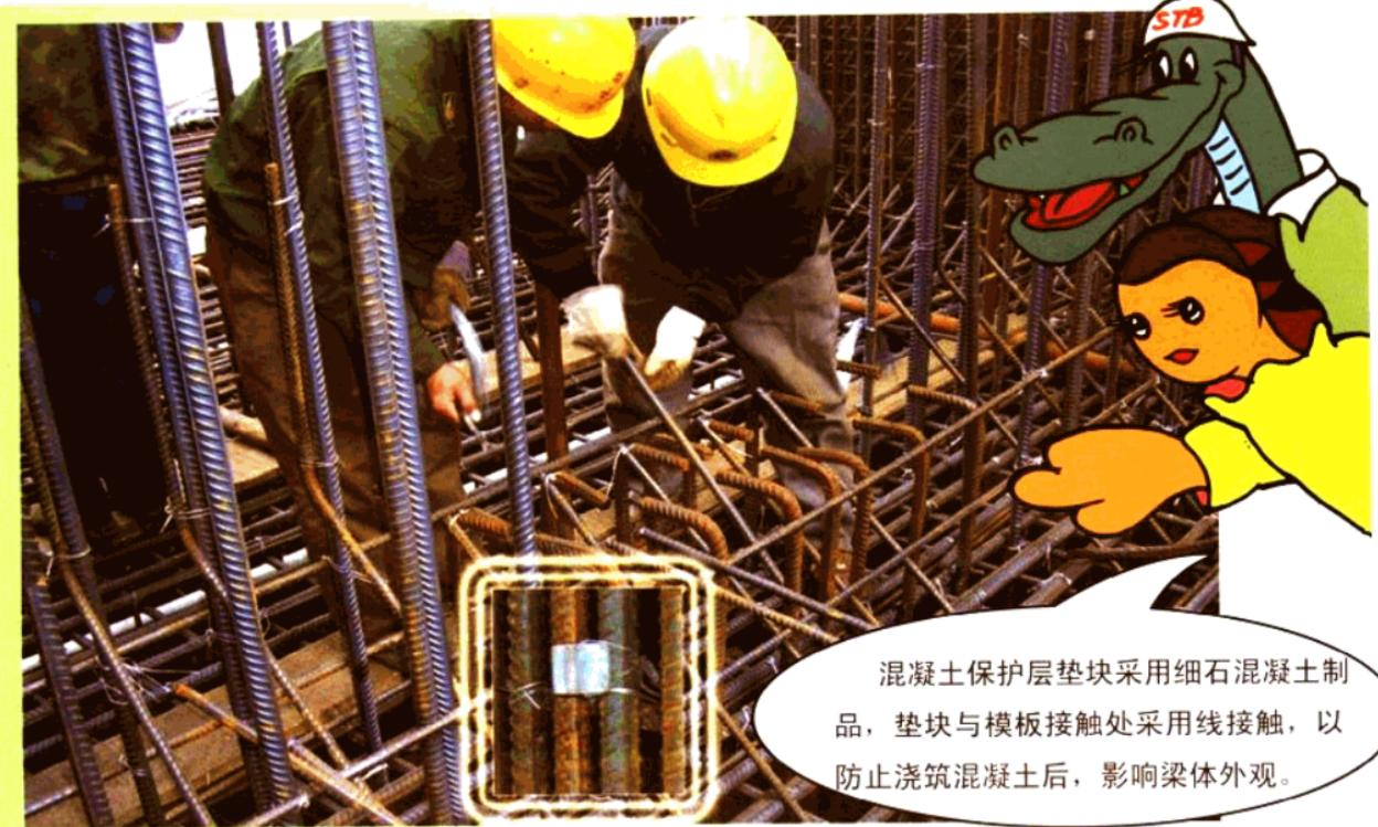
混凝土保护层垫块采用细石混凝土制品，垫块与模板接触处采用线接触，以防止浇筑混凝土后，影响梁体外观。
