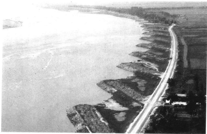
图 1-1 实际河道中建造的丁坝
