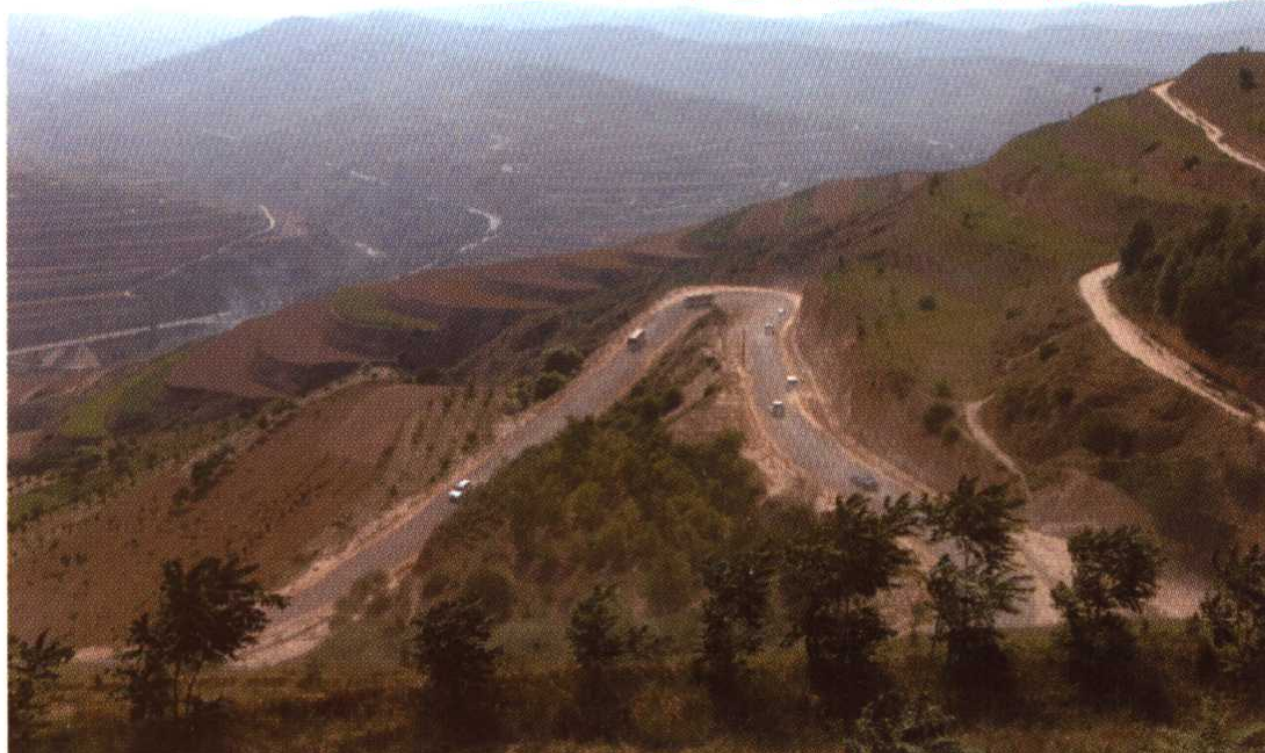
▲ 甘肃静宁双（石铺）界（石铺）农村公路
