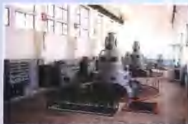
2x2500 千瓦发电机组和一台 800 千瓦机组
