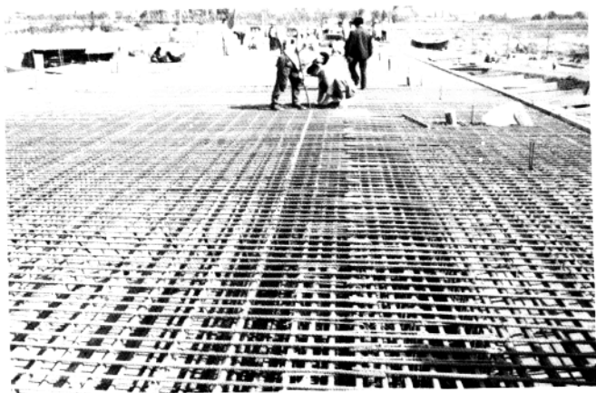
▲ 东外环1号桥施工现场。
