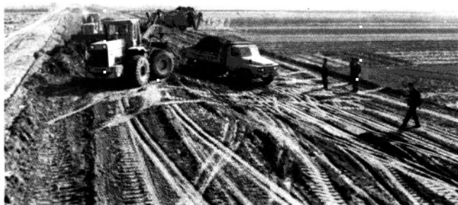
▲ 东清线旅游路拓宽工程施工现场。
