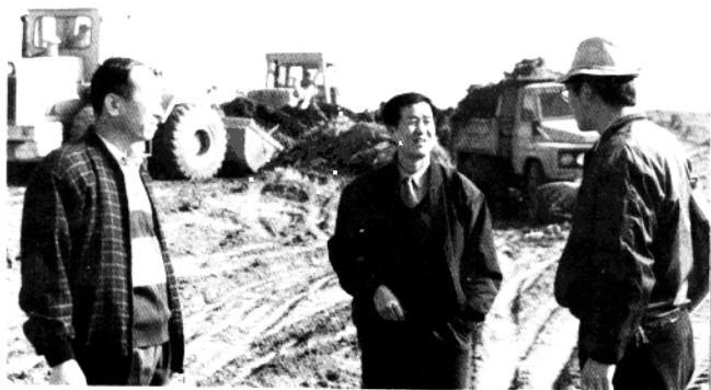
▲ 榆次交通局局长杨转虎(中)在东清线旅游路拓宽工地了解施工进度情况。
