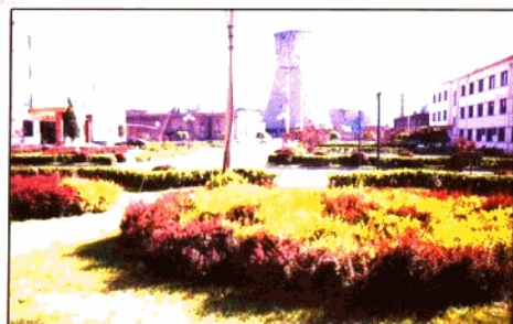
鑫源电力有限公司生产区
