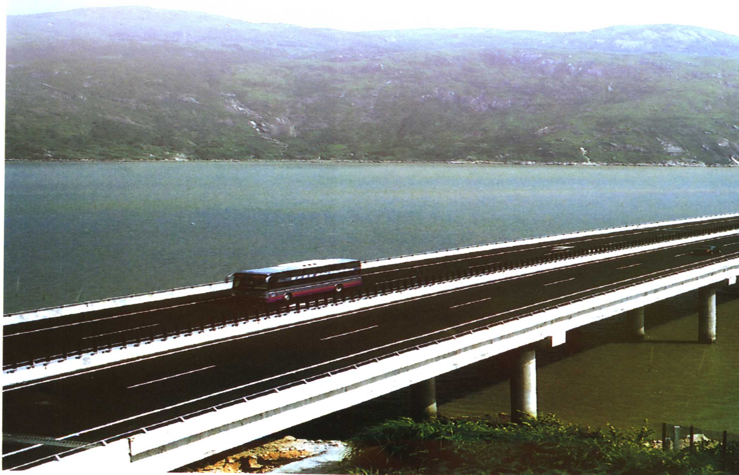
同三高速公路跨海大桥
