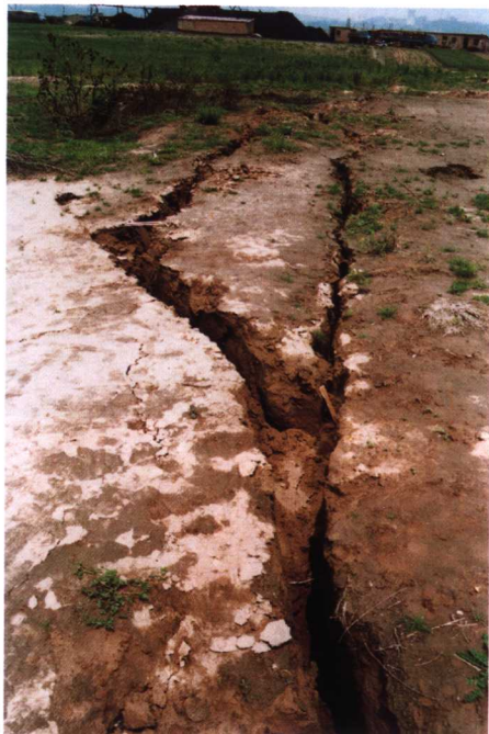
IV-1 矿业活动造成土地开裂
