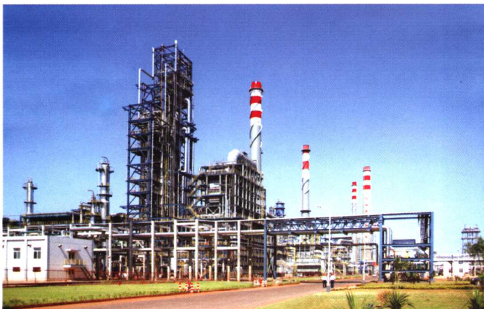
海南实华炼油化工有限公司连续重整装置
