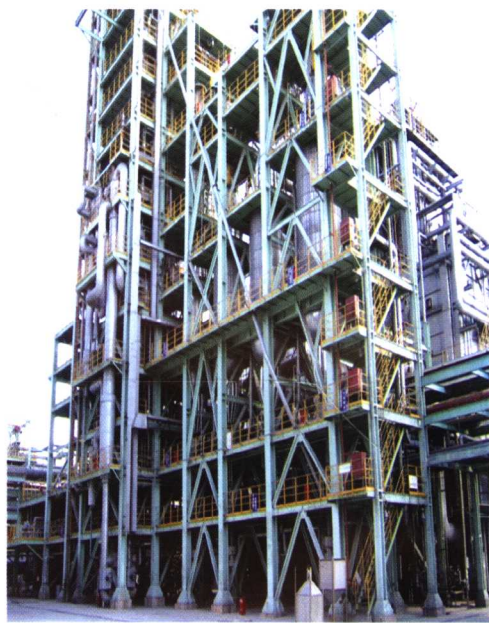
乌鲁木齐石化公司连续重整装置
