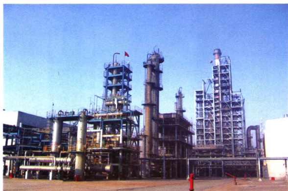
辽阳石化公司芳烃联合装置中的 连续重整部分
