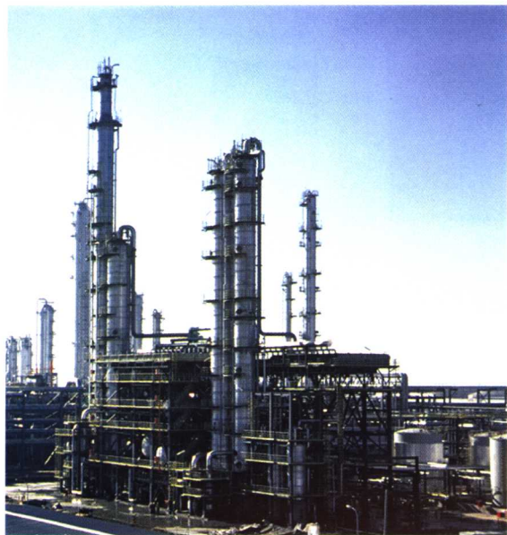
上海赛科石油化工有限公司芳烃抽提蒸馏装置
