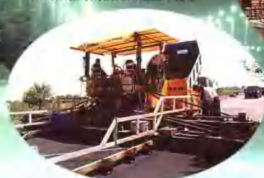
ABG423 摊铺机铺筑油面
