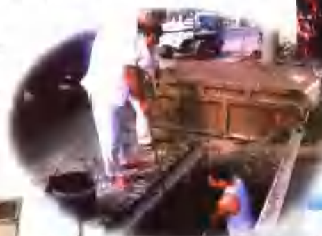
省“五一”劳动奖状获得者，南运大队公厕化粪池清掏清运班王锐车组正在清掏公厕化粪池。
