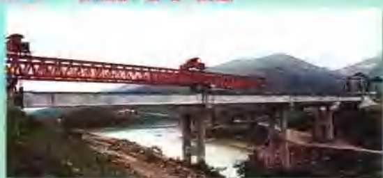
180T架桥机安装207国道汤河大桥
