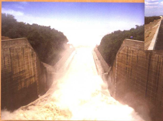
● 主溢洪道泄洪
