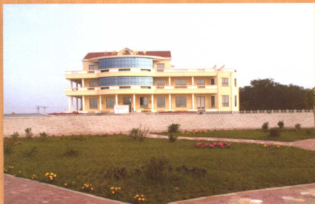
● 溢洪道闸门控制中心楼
