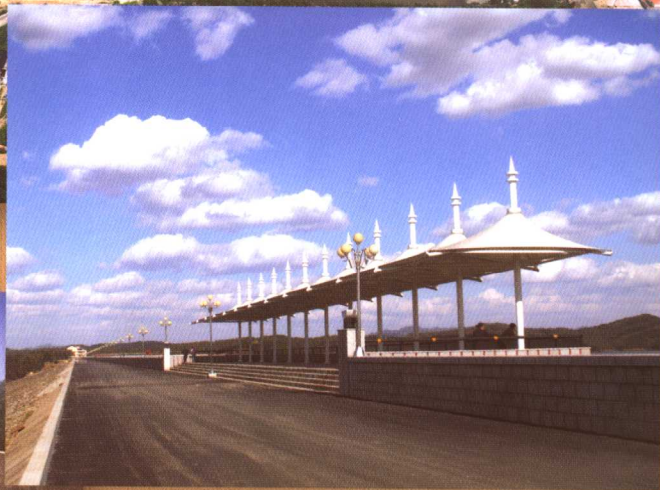
● 除险加固后的水库一角
