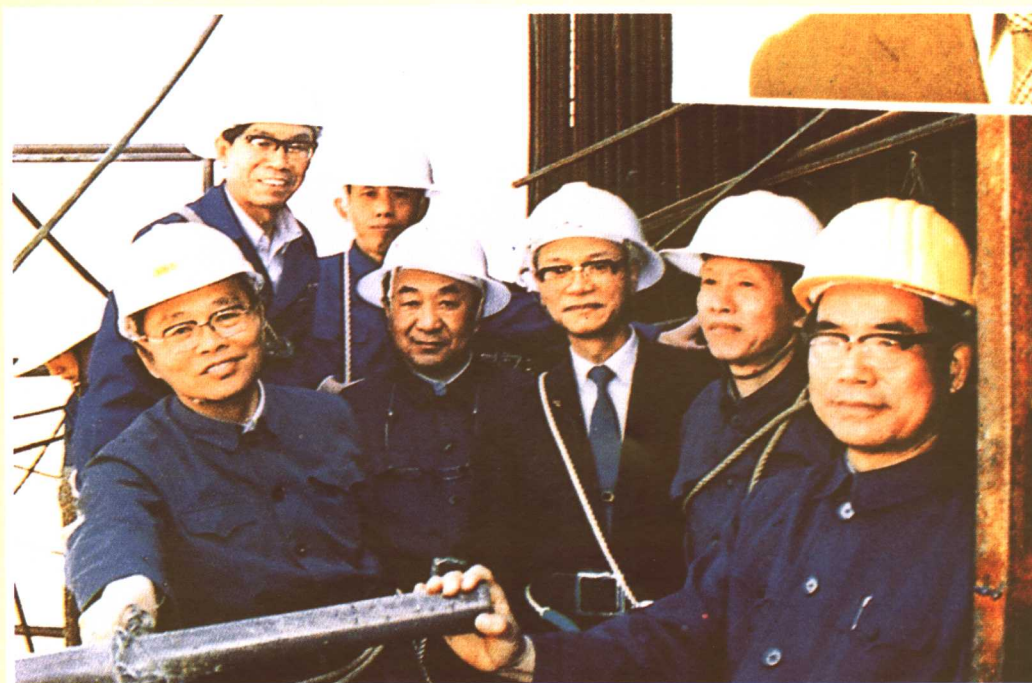
我国自行设计建造的第一座核电站——秦山核电站，潘际銮任焊接工程顾问。照片摄于安全壳高层结构上，右一为工程总负责人欧阳予院士，右三为潘际銮
