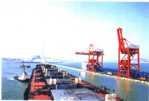
■ 南埔5万吨煤码头一角
