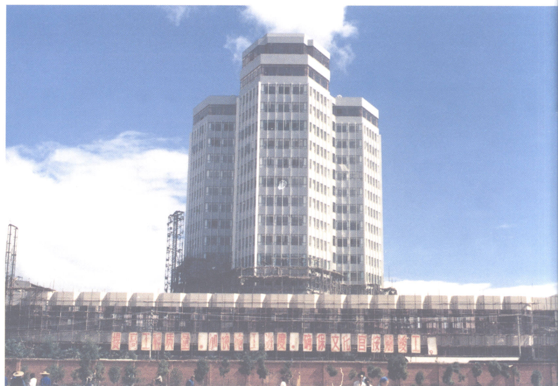
■ 工人文化宫施工现场之三
