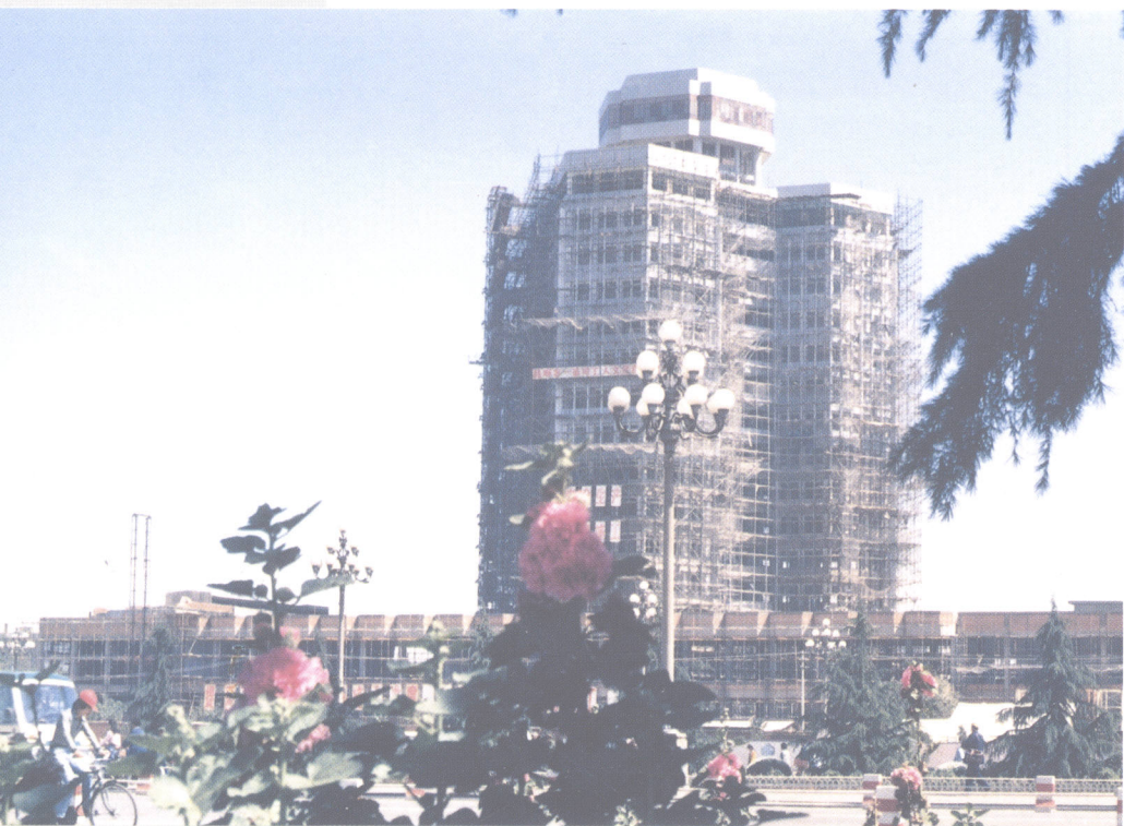
■ 工人文化宫施工现场之一
