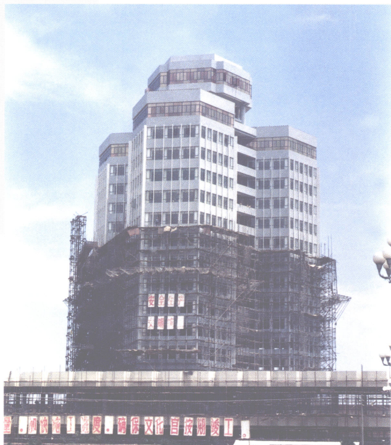
■ 工人文化宫施工现场之二
