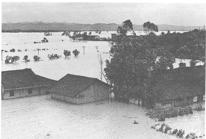
县造船厂和部分民房被淹。 7月14日遂宁
