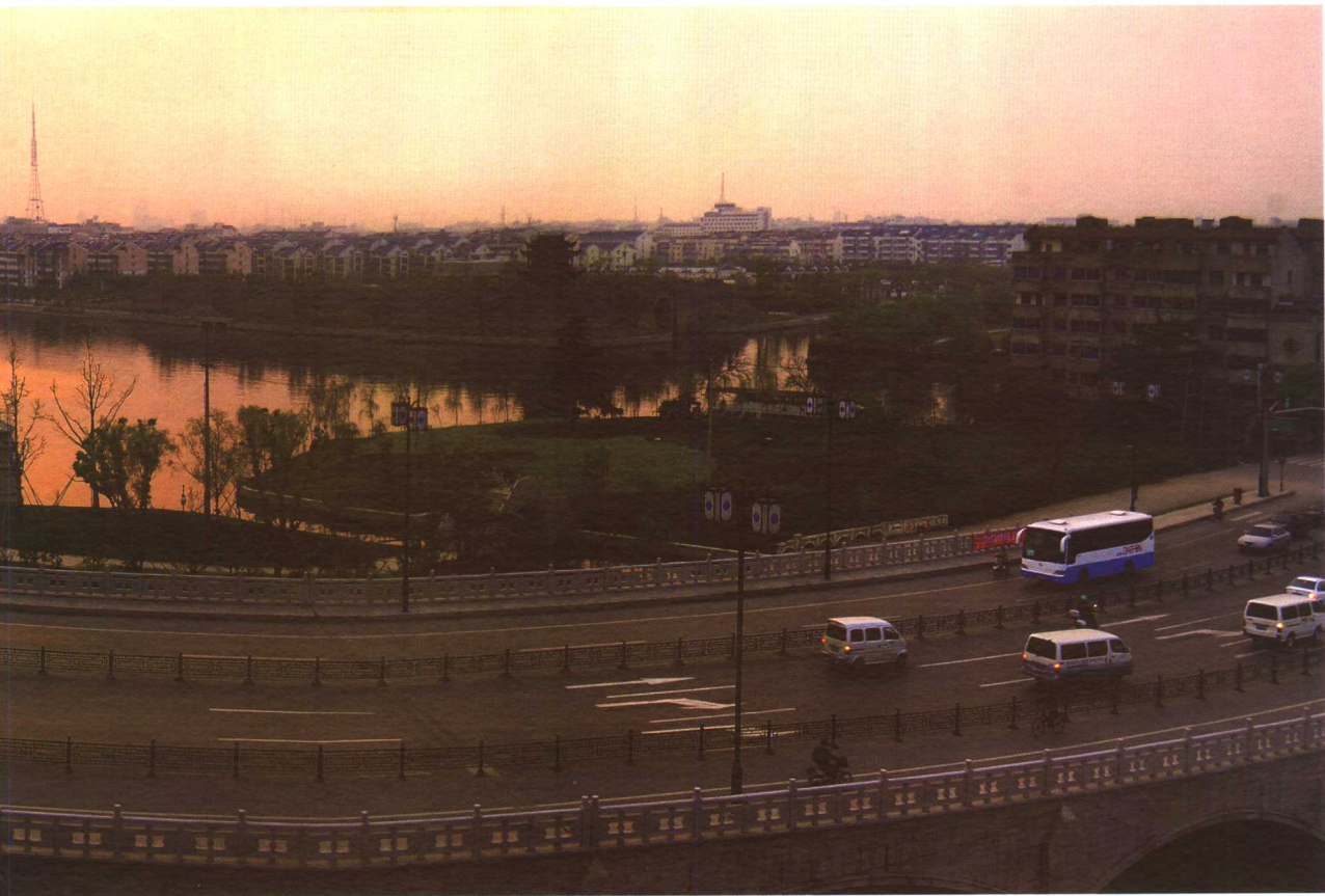
宽渡桥（建于2003年5月）
