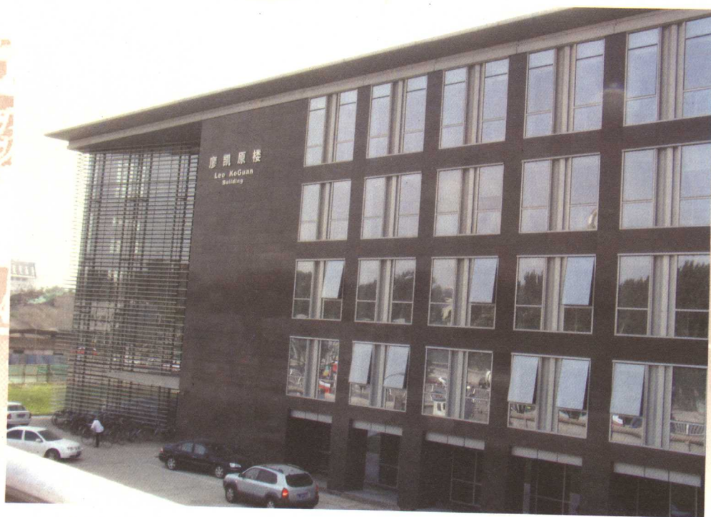
▲ 北京大学法学院、政府管理学院教学大楼。
