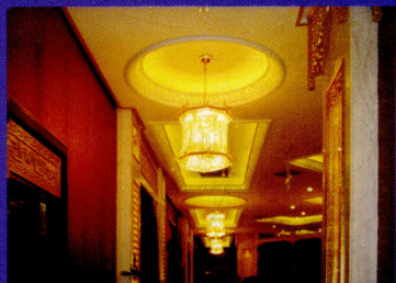
杭州江南喜乐室内暗槽冷阴极灯，灯具根据暗槽形状弯制加工而成，其光源无断点，具有超强视觉穿透力，拥有富丽堂皇的色彩，而被室内设计师广泛采用
