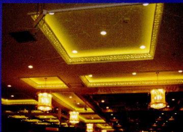
杭州江南喜乐室内暗槽冷阴极灯，灯具根据暗槽形状弯制加工而成，其光源无断点，具有超强视觉穿透力，拥有富丽堂皇的色彩，而被室内设计师广泛采用
