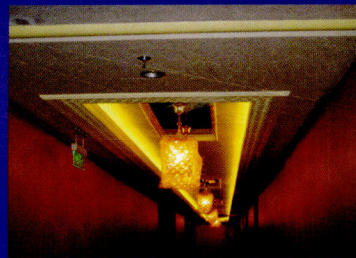
杭州江南喜乐室内暗槽冷阴极灯，灯具根据暗槽形状弯制加工而成，其光源无断点，具有超强视觉穿透力，拥有富丽堂皇的色彩，而被室内设计师广泛采用
