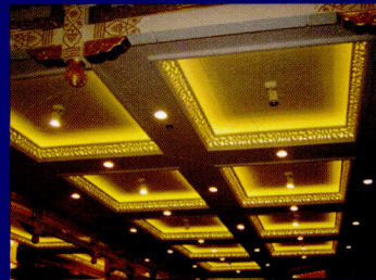
杭州江南喜乐室内暗槽冷阴极灯，灯具根据暗槽形状弯制加工而成，其光源无断点，具有超强视觉穿透力，拥有富丽堂皇的色彩，而被室内设计师广泛采用
