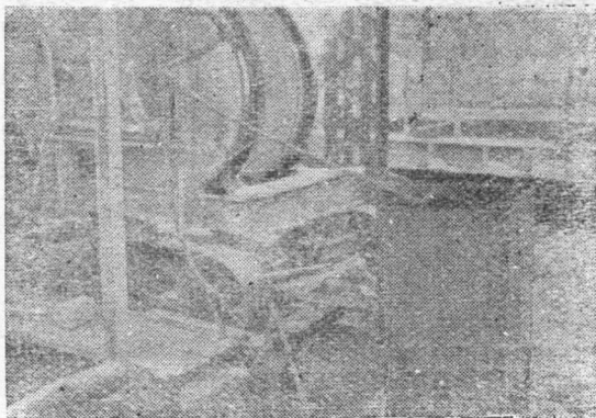
圖 5 電熱器煮水, 通到拌和機使用
